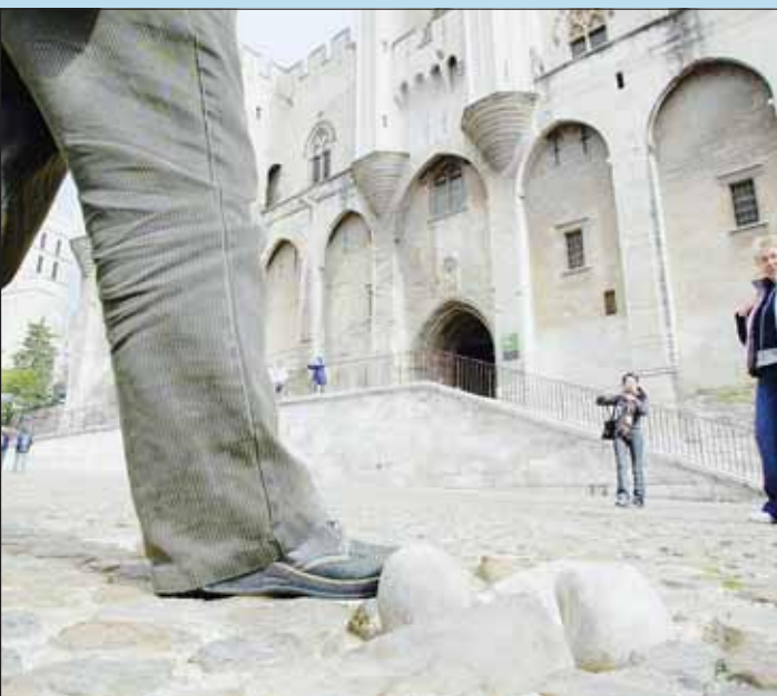
Le parvis perd ses pierres. Un côté inesthétique certes mais aussi dangereux sur cette place très fréquentée. / PHOTO CYRIL HIÉLY
